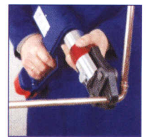
préselés, a kész kötés jelölése
