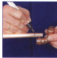
betolási mélység jelölése
