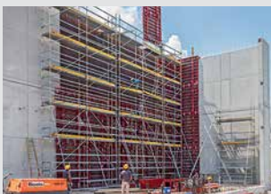
Állványok betonacél szereléshez
