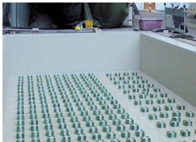
Mit Bilz Isolierplattensätzen ausgelegte Fundamentwanne
