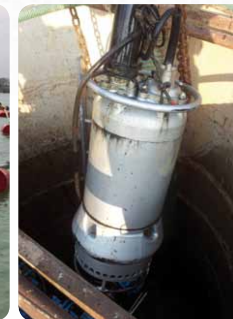
Homokkal szennyezett víz átemelése
