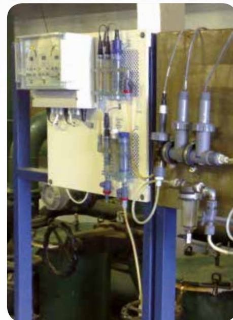
pH, Redox és Klór mérő szabályozó rendszer
