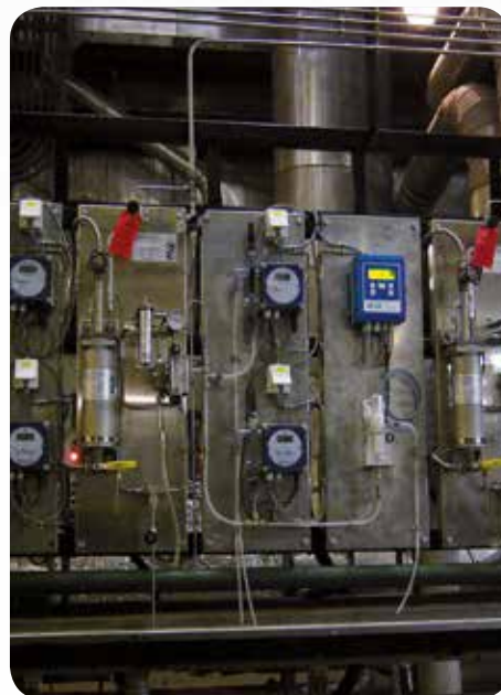
Erőművi pH és vezetőképességmérő rendszer
