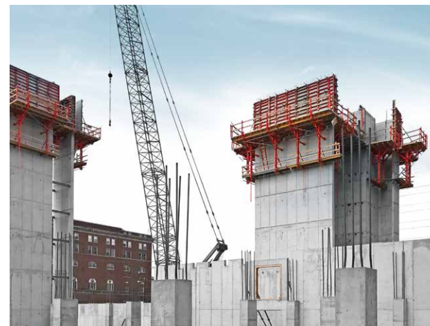
A KLK 230-as kúszóállvány kúszókonzolból, faltámaszokból, padlózatból és korlátokból áll.
