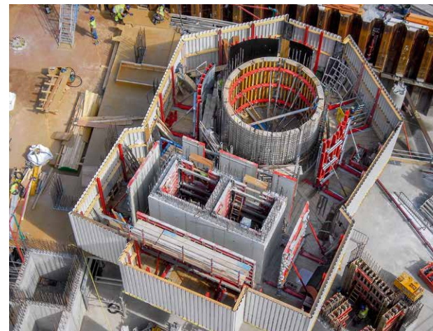
Bonyolult geometriák, különböző nagyságú, egymáshoz képest eltoltt épületszerkezetek is problémamentesen megvalósíthatók a vezetett MGC-H kúszorendszerrel.
