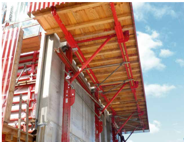
Mindig fixen rögzül az épülethez, mind az építkezés, mind a kúsztatási fázis alatt.
