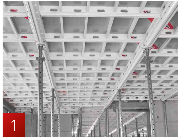
Ejtőfej-tartó-elem (FTE) módszer
