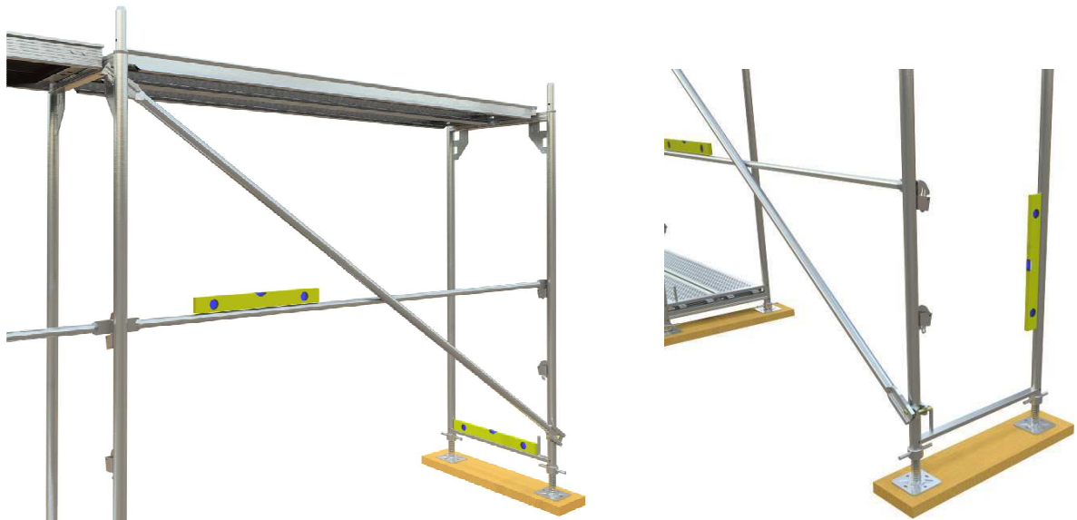
7. ábra Az állvány szintezése
