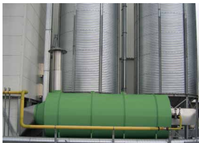
Indirekt léghevítő gázegővel
