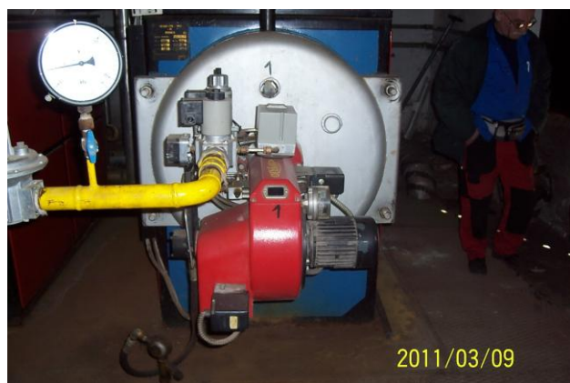
TP 400/M típusú, 465 kW teljesítményű referencia kazán
