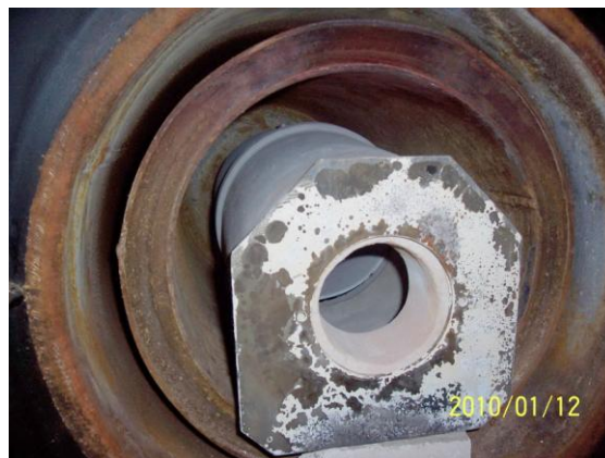
Az ECONOCO reaktor installálása
