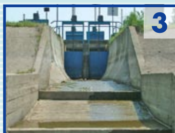
3 ÖNTÖZÉS VASBETON ELEMEI
